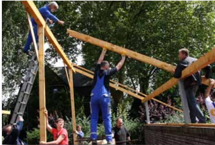
Viele fleißige Bislicher packten beim Bau der Garage an und setzten die Planungen von Franz Schweers in die Tat um.
