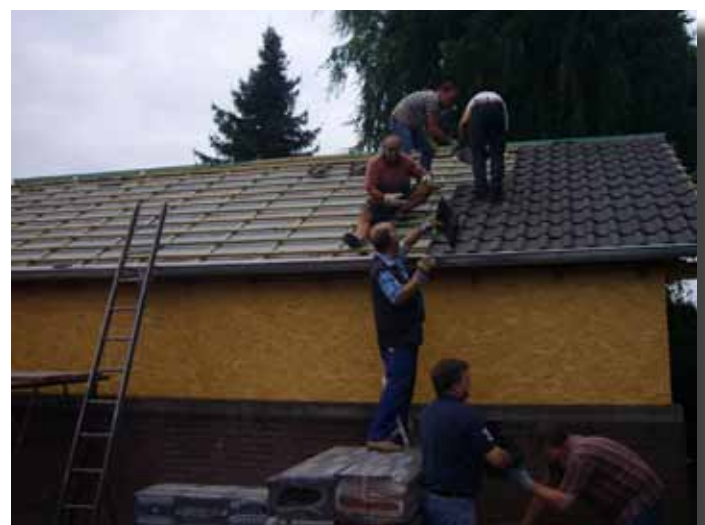
Nach unzähligen Arbeitsstunden war es endlich soweit. Das Dach wurde eingedeckt. Die restlichen Arbeiten können jetzt wetterunabhängig durchgeführt werden.
