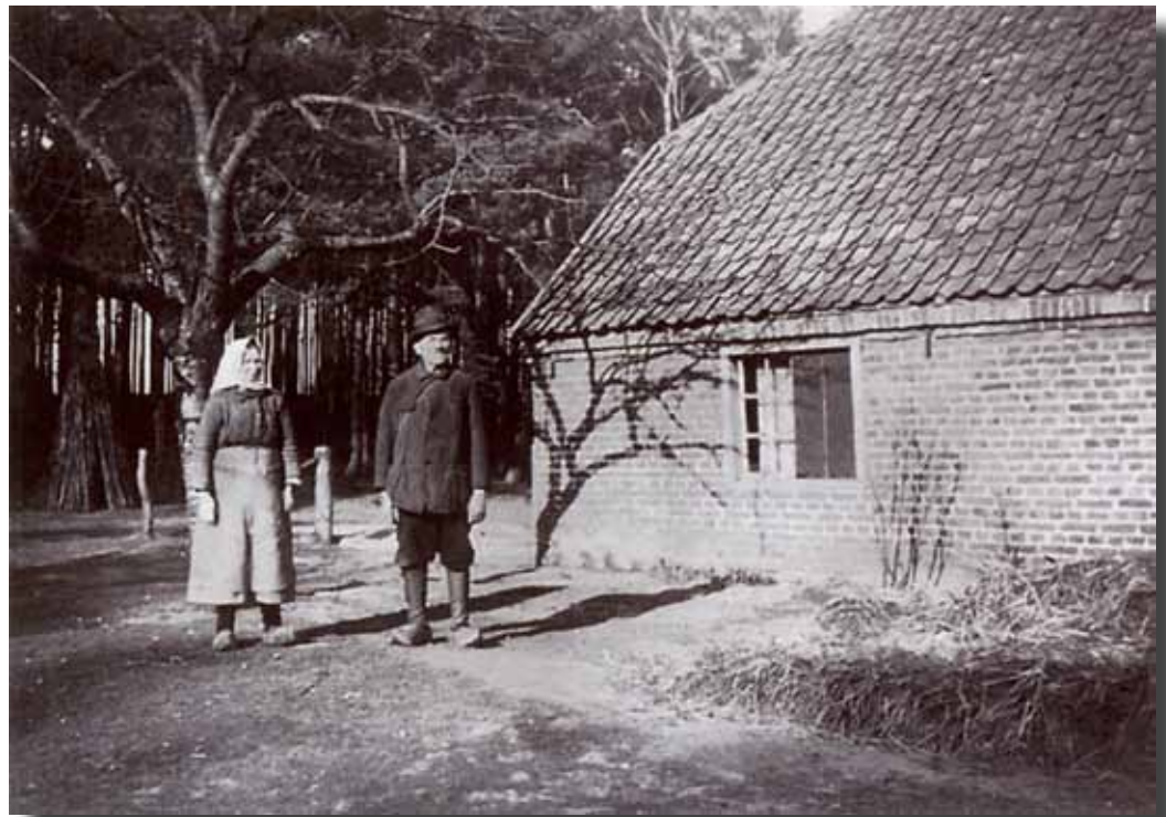
Nach dem Tod der Eheleute wurde die im Krieg beschädigte Katstelle abgerissen und aus dem Material Ställe gebaut, in denen Schweine, zwei Kühe und drei Bullen zur Mast gehalten wurden.
